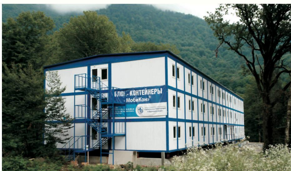
Рисунок 3. Сборно-разборное трёхэтажное здание из блок-контейнеров (г. Сочи)
