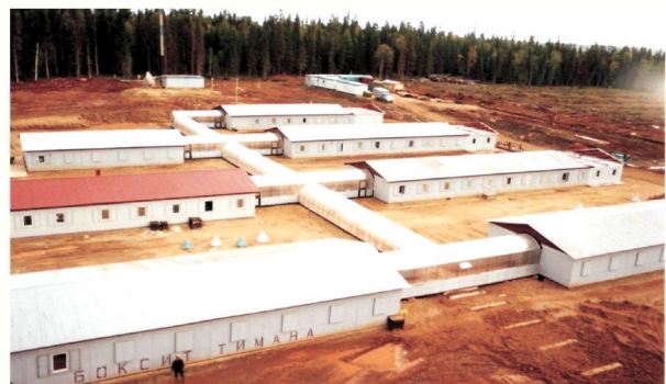
Рисунок 4. Вахтовый посёлок с пешеходными галереями (площадь 1880 м²) в Республике Коми, Средне-Тиманский рудник
